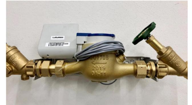
Integration des LoRaWAN™-Funkmoduls am bestehenden GWF Wasserzähler im Netz
