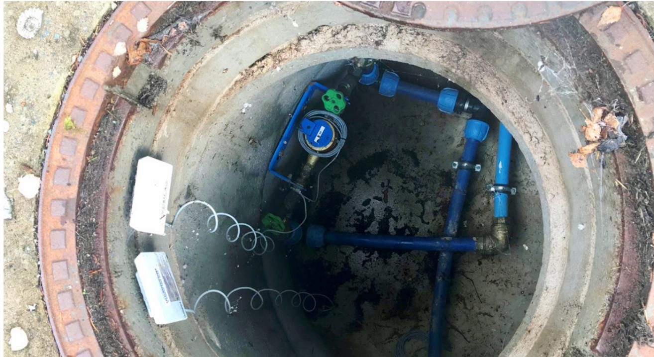
LoRaWAN™-Funkmodul ermöglicht beste Übertragungsqualität
