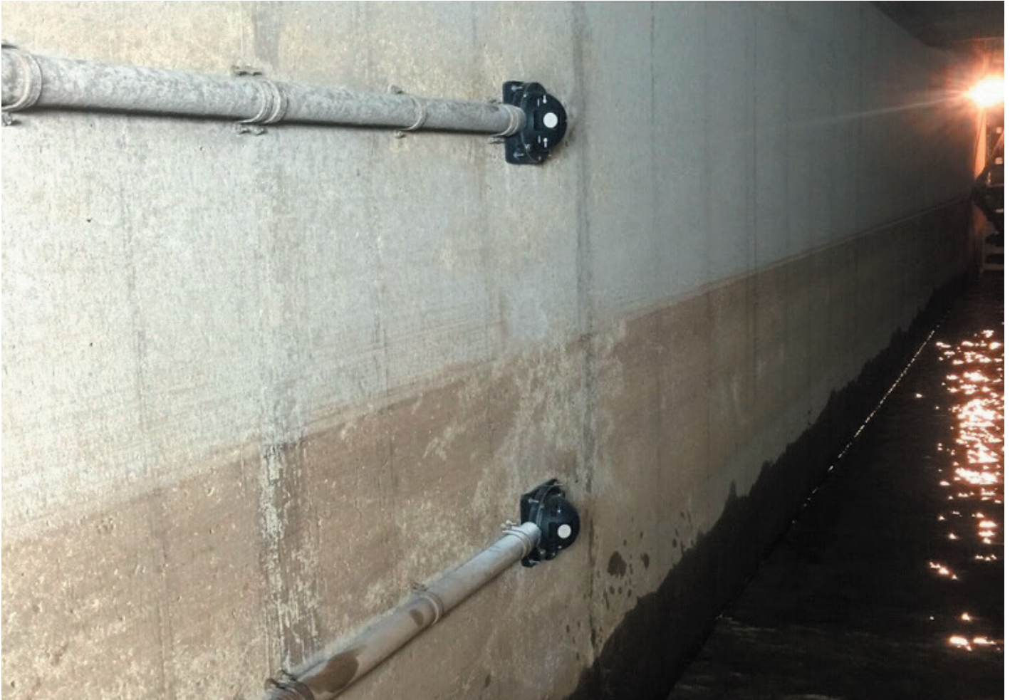
Installation von Kanalis-Sensoren in der Wasseraufbereitungsanlage Jardine
