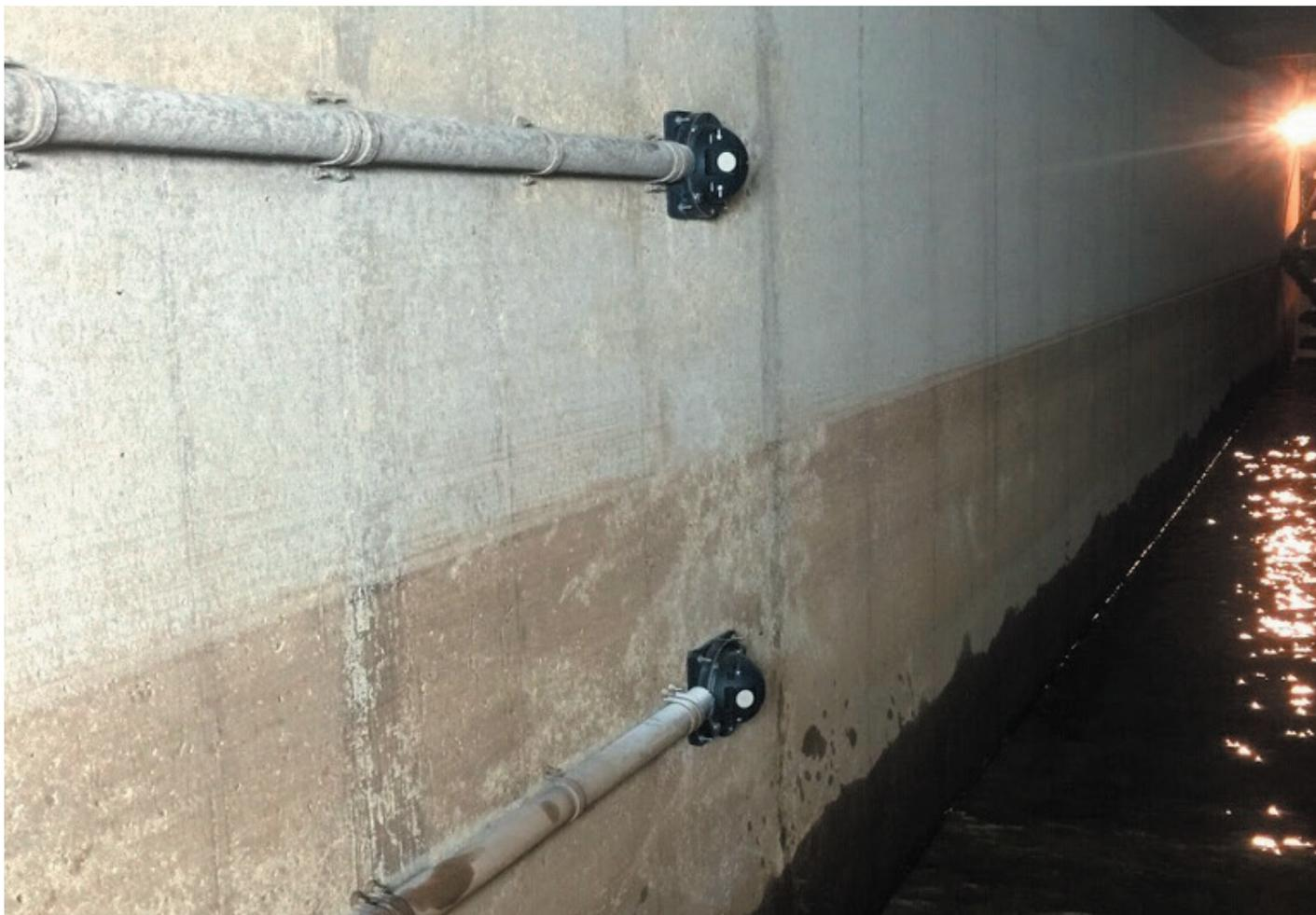
Installation de capteurs Kanalis dans la station d'épuration des eaux de Jardine
